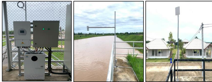
รูปที่ 2-14 การติดตั้งนวัตกรรมระบบควบคุมบานระบายทางไกล
